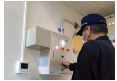
(写真6-2) 陽圧化装置の起動確認
