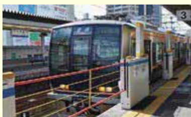
〔昇降ロープ式ホーム柵〕
